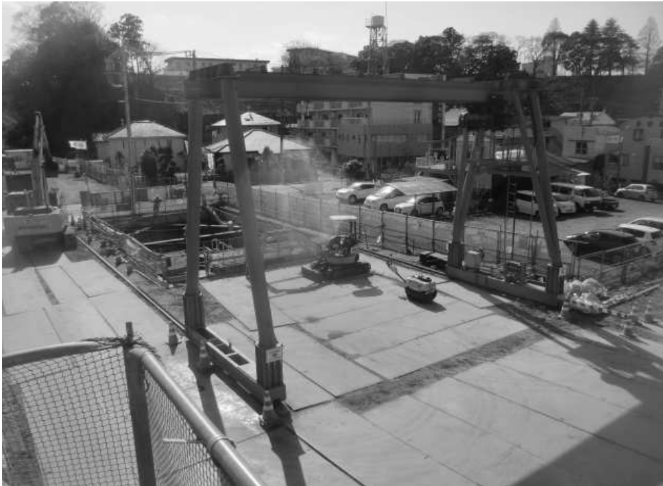
国営那珂川沿岸農業水利事業で改修工事が始まった大杉山揚水機場
