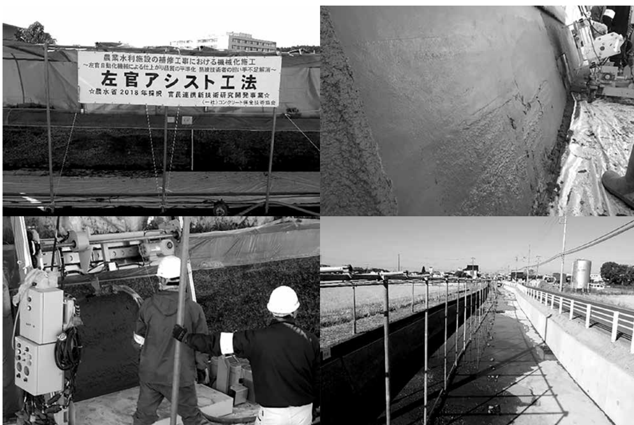
国営那珂川沿岸農業水利事業による備前堀改修工事（酒門町）
